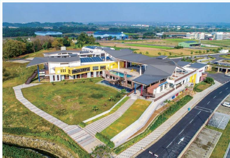
▲整體設計除大面積綠化、保水透水鋪面、節能及水資源回收設備，並裝設太陽能發電設備，可節省25%的用電量。
